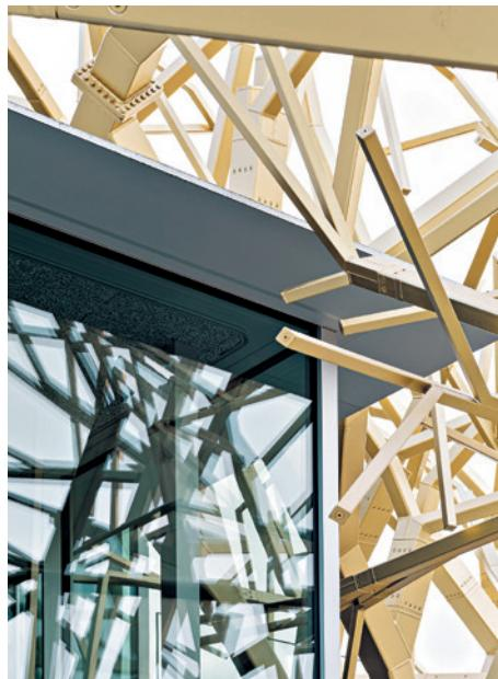
Die Stahlbäume sind mit 3D-Simulationsprogrammen so berechnet, dass die feinen Äste selbst bei Sturm nicht gegeneinander oder gegen das Gebäude prallen.
