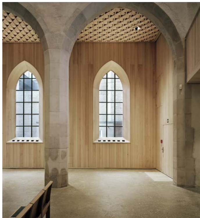
Abb. unten rechts: Die im Diagonalverband ausgeführte Deckenkonstruktion aus unverleimten Vollhölzern formt den Innenraum mit der Anmutung eines Flechtwerks. Die Konstruktion dient auch der Behausung der Lichtinstallation.
